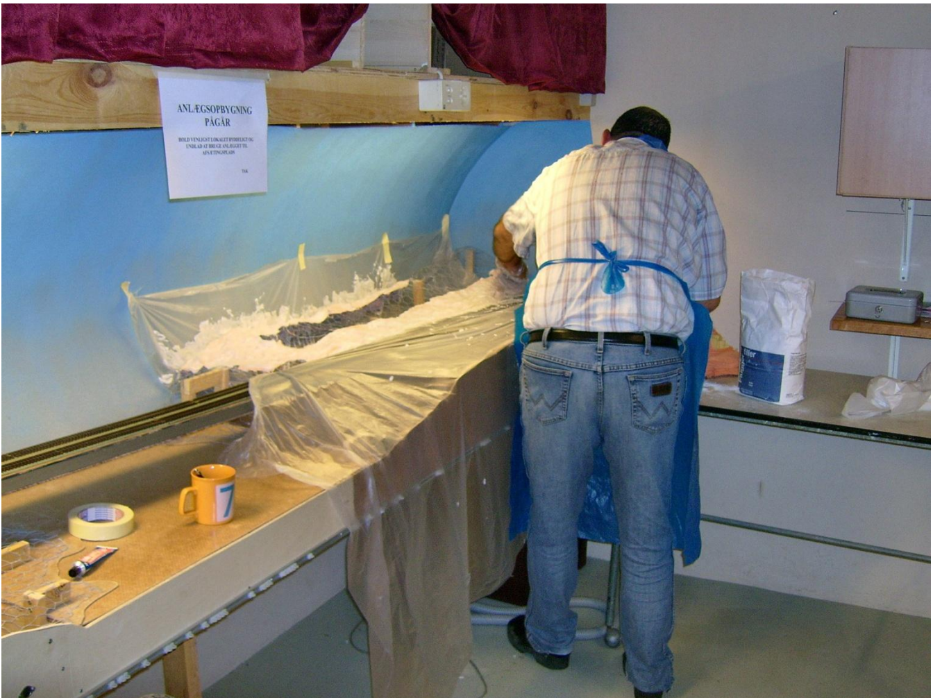
Jan er her i fuld gang med at beklæde hønsenettet, det ser lovende ud! Man kan se at den grundige afdækning på ingen måde, er overdrevet.
